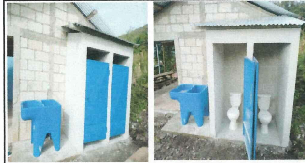
Foto 4: Construccion formal de block servicios sanitarios(baños).
