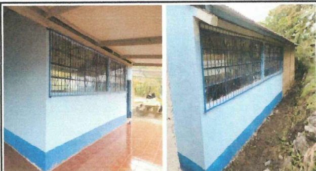
Foto1: Fabricacion e instalacion de balcones de metal
