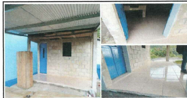
Instalacion, puerta, ventana, piso ceramico, techado corredor de la cocina.
