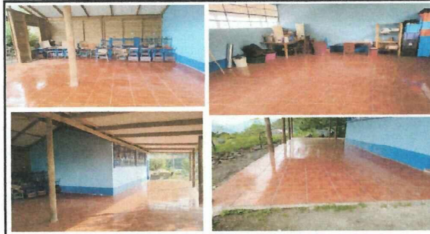
Foto 2: Instalacion de piso ceramico en el aula.
