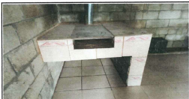
Foto 5: Mejoramiento de polleton e instalacion de plancha.
